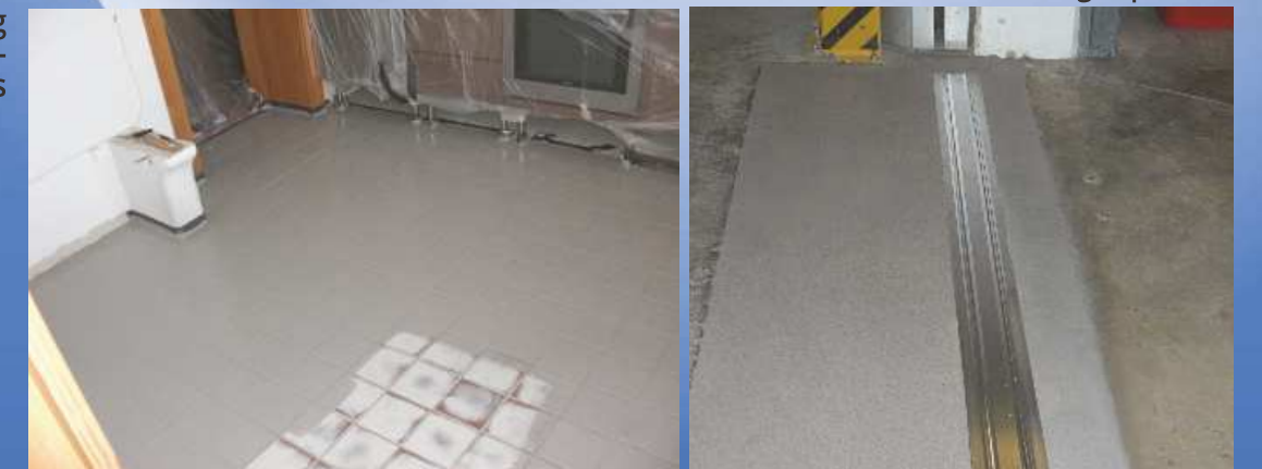
Einbau eines Fugenprofils
